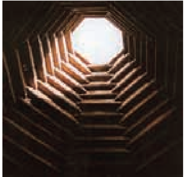
კახეთი, სოფ. გიორგიმინდა. დარბაზი. გირგინი (1850-1853 წწ.) ფოტო: ნანა მეფარიშვილი. პროექტი: „ქართული სახლი“. კომპანია არსი Kakheti, Giorgitsminda. Darbazi. Corbel vault (1850-1853) Photo by Nana Meparishvili; project "Georgian House", Company ARCI
