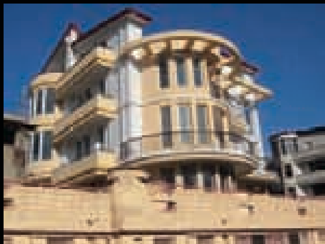
საცხოვრებელი სახლი. უნივერსიტეტის ქ #50. 2001-2004 აჩიქტეუქსოი: თ.მუხვანიძე. კონსტრუქტორი: ზ. სილაგაძე Residential House in 50 Universiteti str. 2001-2004. Architect: T. Murvanidze. Cosntructor - z. Silagadze
