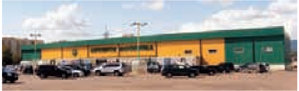
გიპერმარკეტ "გუდვილის" რეკონსტრუქცია ქ. თბილისი, ფარნავაზის ქ. №1. 2006 წ. "Goodwill" hypermarket in 1 Parnavazi street, Tbilisi. Reconstruction. 2006.
