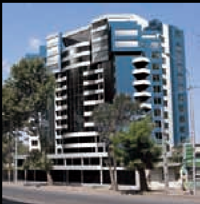
საცხოვრებელი სახლი. ჩოლოყაშვილის ქ #48. აჩიქტეუქსოი: თ.მუხვანიძე, ვ. გოგავა. კონსტრუქტორი: ზ.სილაგაძე Residential House in 48 Cholokashvili str. Architects: T. Murvanidze, V. Gogava. Cosntructor - Z. Silagadze
