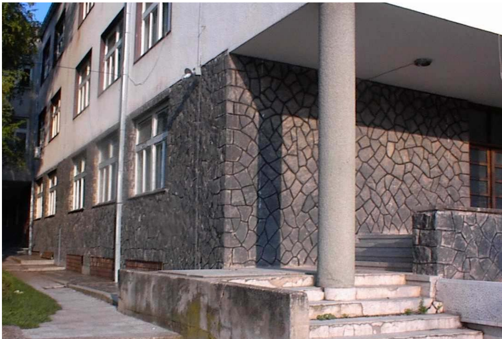
Сл. 13. Употреба на базалтот како конструктивен елемент
