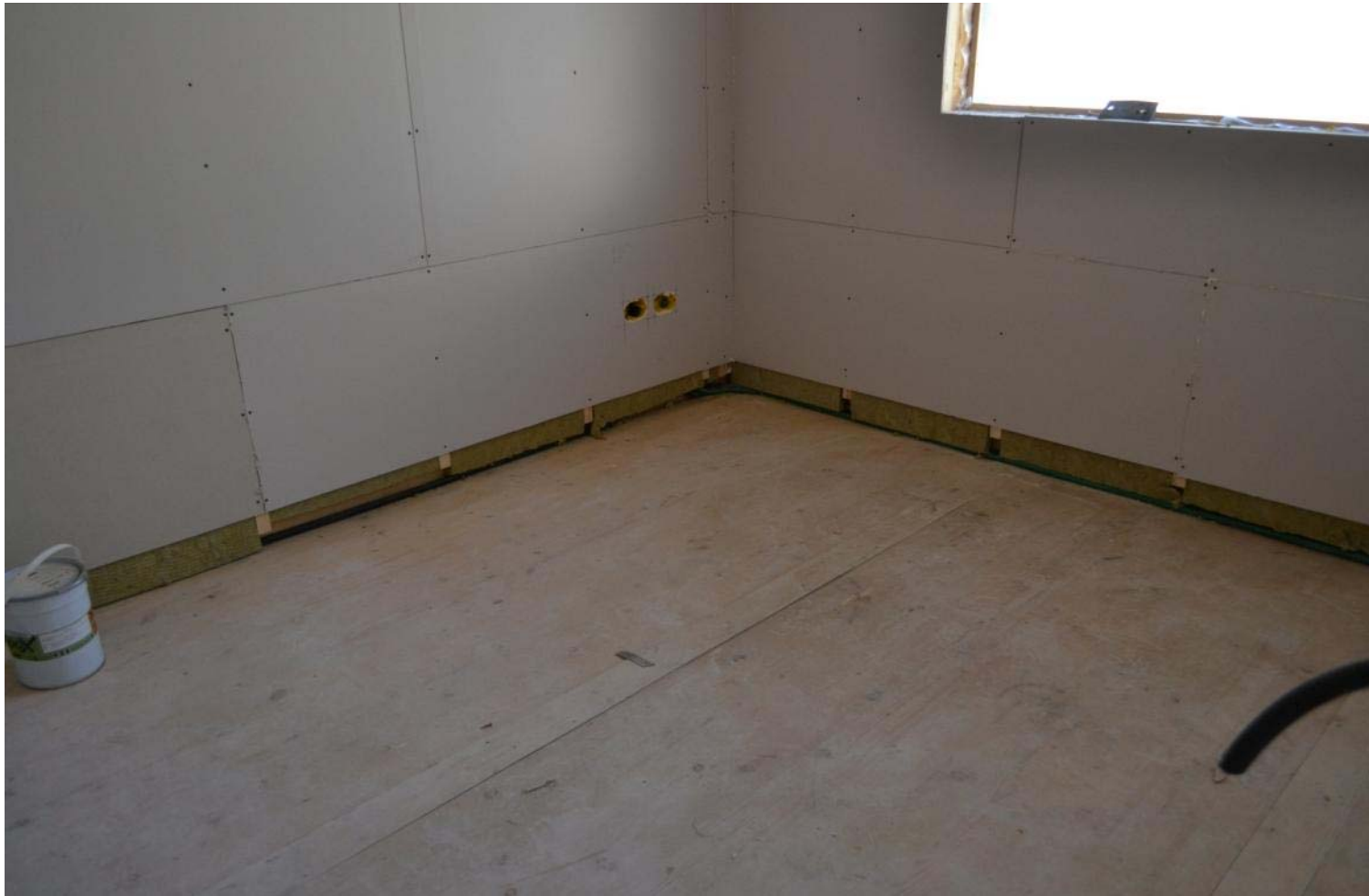
CHIUSURA CONTROPARETE CON PANNELLO OSB 15 mm + PANNELLO CARTONGESSO 13 mm
