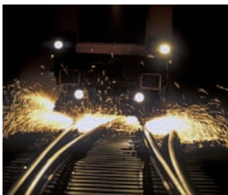
Besonders überwachtetes Gleis: der Schienenschleifzug im Einsatz
