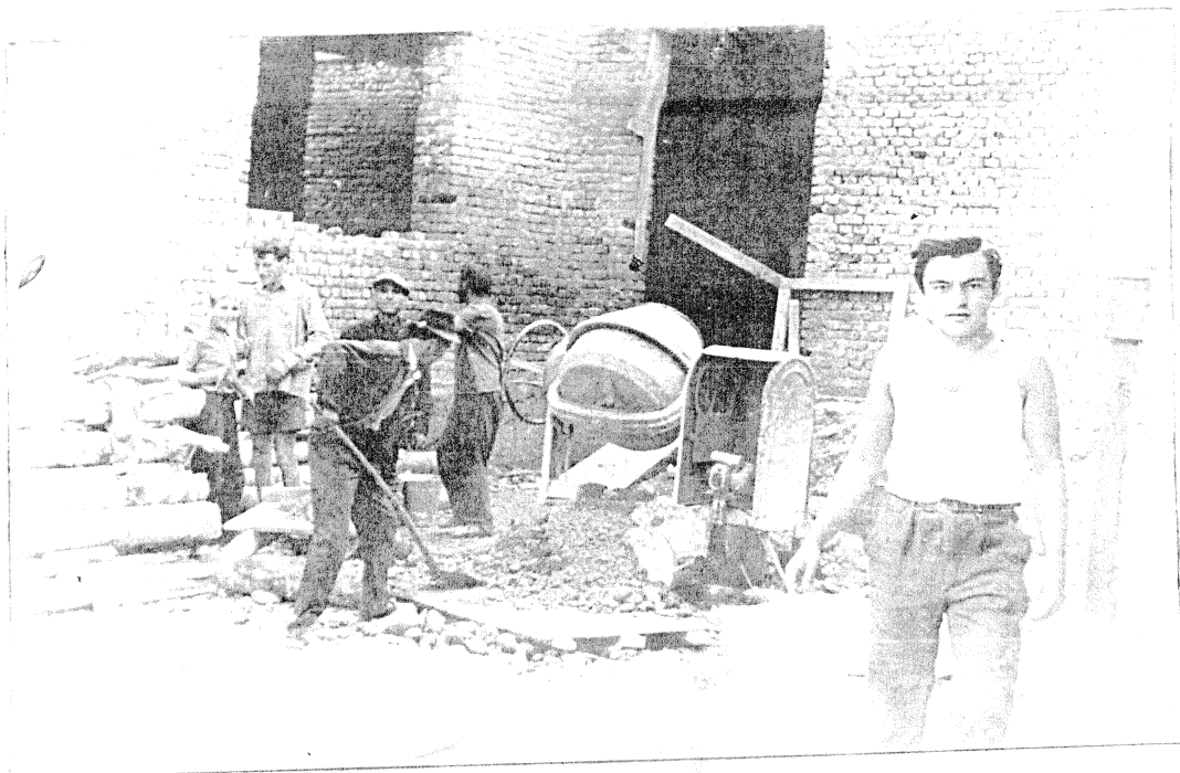
Lucratori voluntari la clădirea perlii noi, la drum spre -
