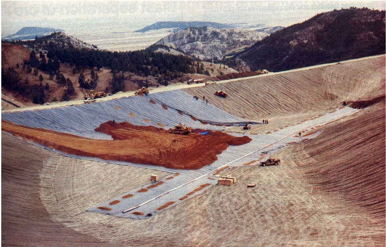
Φωτ. 1.6: Κατασκευή σωρού εκχύλισης χρυσού διπλής βαθμίδας στη Montana, USA.
