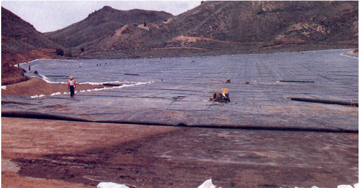
Φωτ. 1.5: Κατασκευή σωρού εκχύλισης χρυσού απλής επίστρωσης στο Idaho, USA
