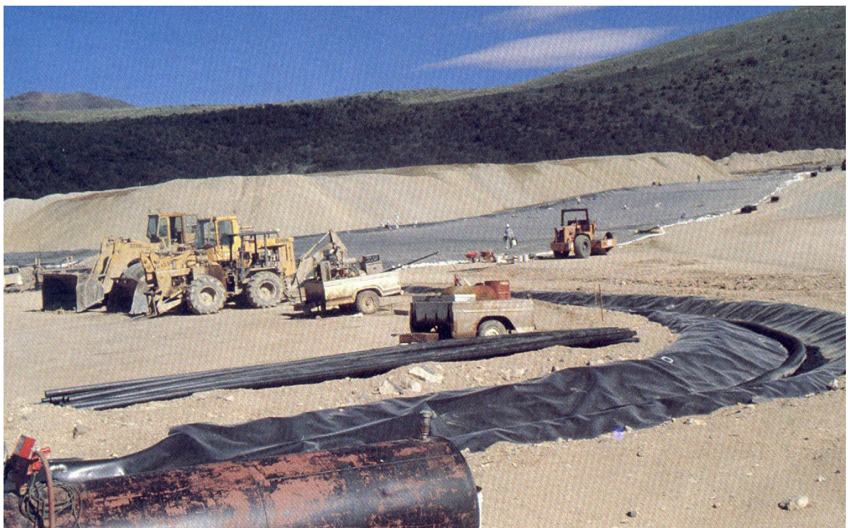
Φωτ. 1.7: Κατασκευή σωρού εκχύλισης χρυσού με απόθεση με φορτωτές (Nevada, USA)
