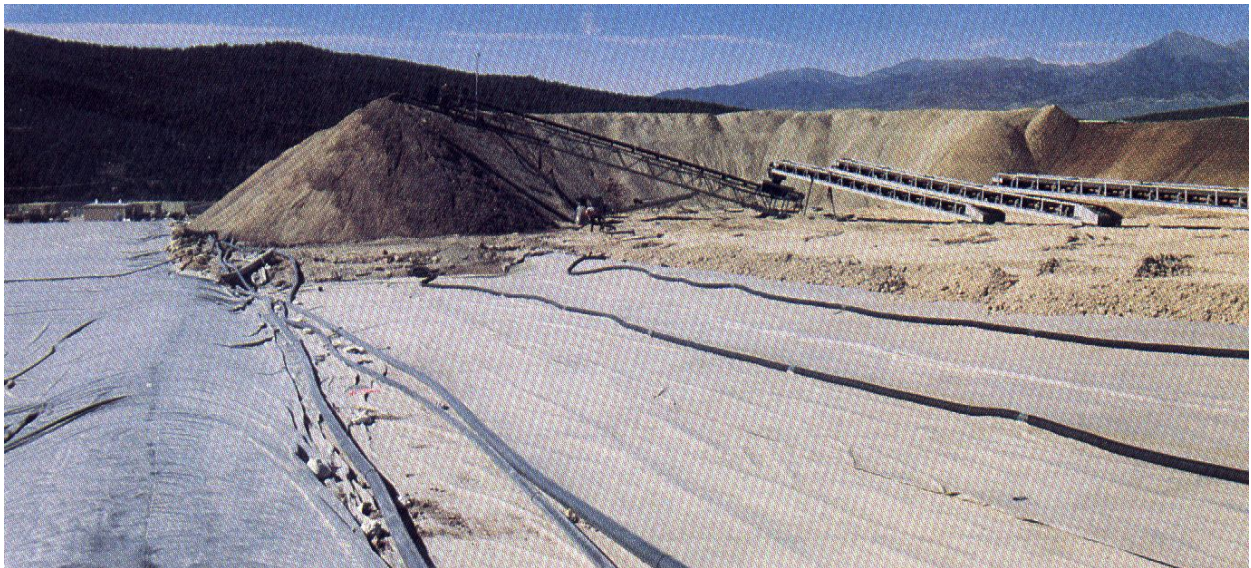
Φωτ. 1.8: Κατασκευή σωρού εκχύλισης χρυσού με μεταφορική ταινία και αποθέτη (Nevada, USA).
