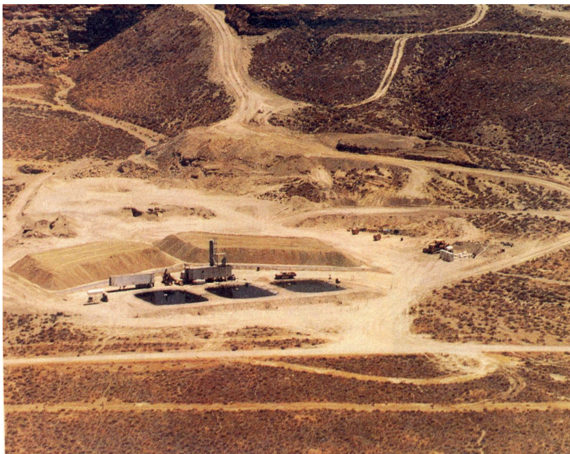
Φωτ. 1.3: Εκχύλιση χρυσού σε σωρό μίας βαθμίδας. Εταιρεία Granges Exploration, Nevada, USA.
