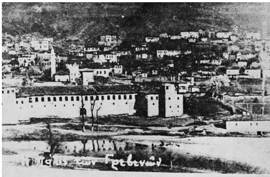
Εικ. 6. Τα κονάκια του «μπέη», στα Γρεβενά. Στο βάθος η πόλη των Γρεβενών (φωτογραφία γύρω στα 1920)
