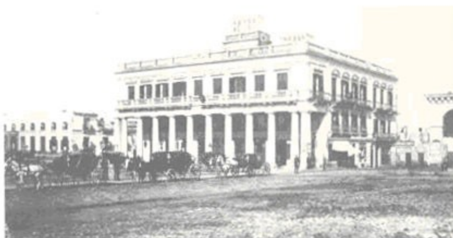
El Palacio Estévez en 1879, antes de instalarse en él la sede del Poder Ejecutivo.
