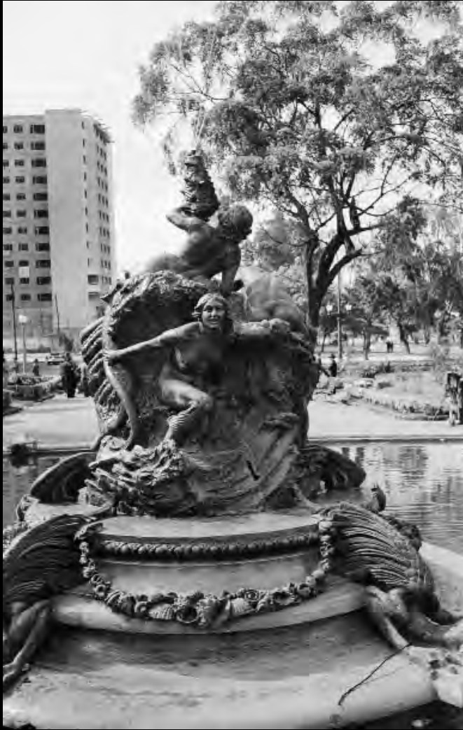
Fuente elaborada por Francisco Antonio Cano, Felix María Otalora y José C. Rodríguez. Inaugurada el 25 de Octubre de 1920, emplazada en el Parque de la Independencia. Fue retirada para dar paso a las obras de viaducto de la calle 26. Archivo Museo de Bogotá
