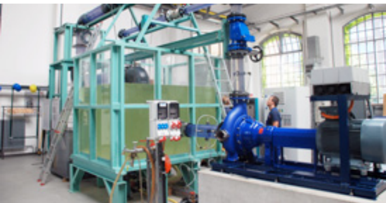
Abb. 3 „Gläsernes Pumpwerk“, die Modellnachbildung einer kompletten Pumpstation in der Versuchshalle K
