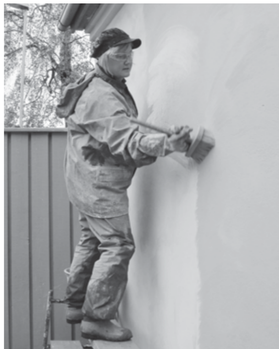
Marja Lammentausta kalkkimaalaa saunan seinää. Työ vaatii hyvän suojautumisen ja oikeat työvälineet ja tekniikat: maali hierretään pintaan kalkkiharjalla monensuuntaisin vedoin ja vähintään kolmeen kertaan ensin kalkkivedellä pohjustaen.
