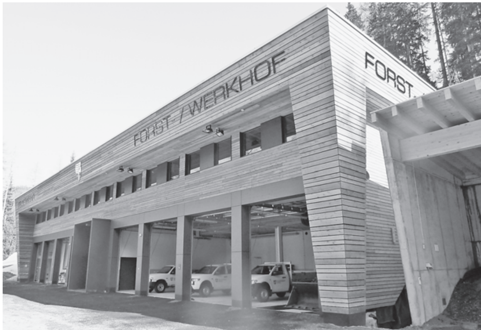
Der neue Forst- und Werkhof mit Feuerwehrrhalle in Samnaun.
