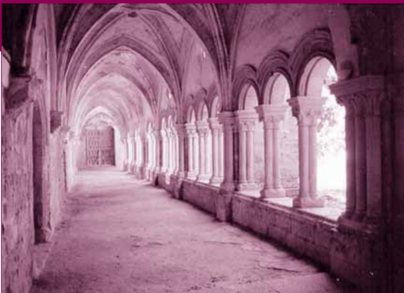
Galería del Claustro.
