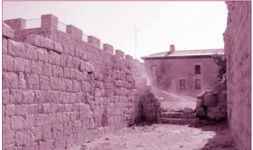
Callejón de la panda norte del claustro desde el oeste.
