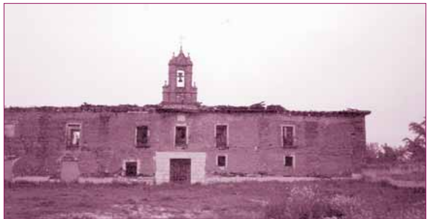
Priorato de La Flecha. Fachada y espadaña, año 2000. Fot. Marisa Álvarez.
