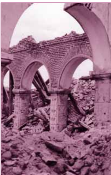
Vista de algunos arcos, donde se aprecia como se conjugan perfectamente piedra y ladrillo. En el momento de la demolición del edificio, año 2000. Fot. Marisa Álvarez.
