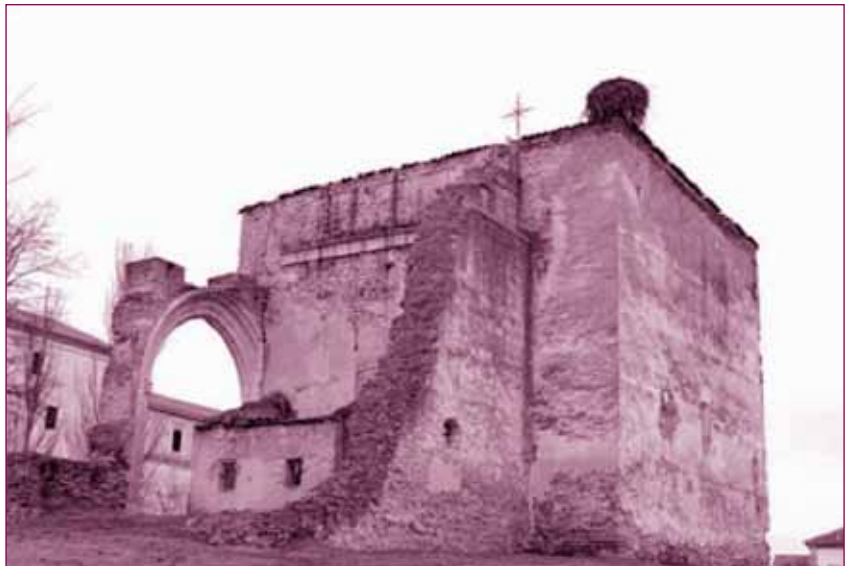
Ruinas de la capilla de Doña María de Toledo, en proceso de restauración.
