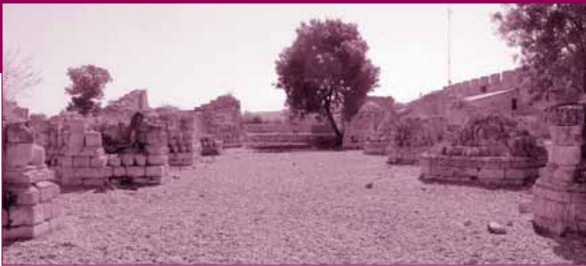
Vista general de la nave central desde los pies.
