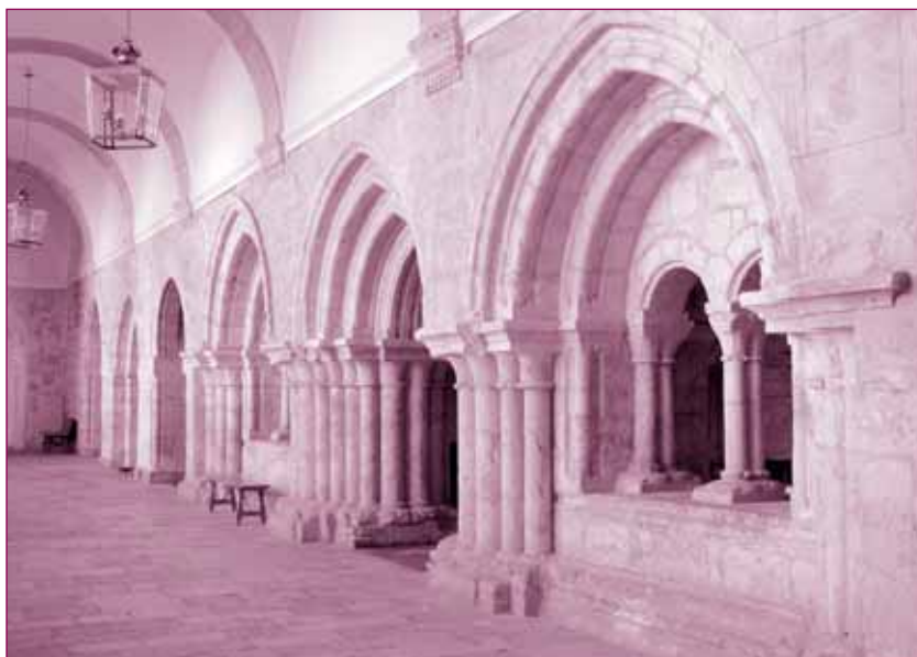
Galería y Claustro.
