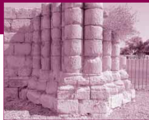
Nave norte. Medio pilar-responsión.
