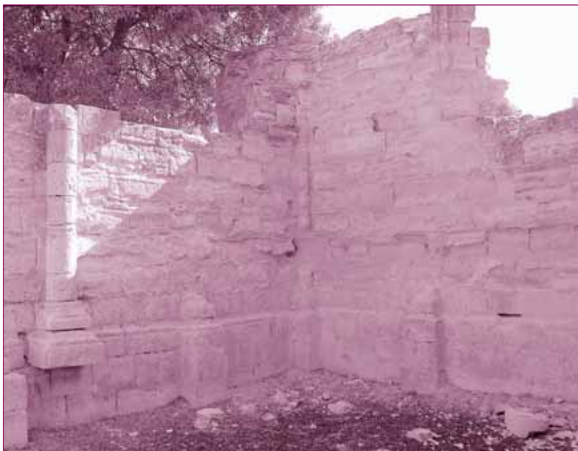
Capilla de San Bernardo, detalle de los soportes.
