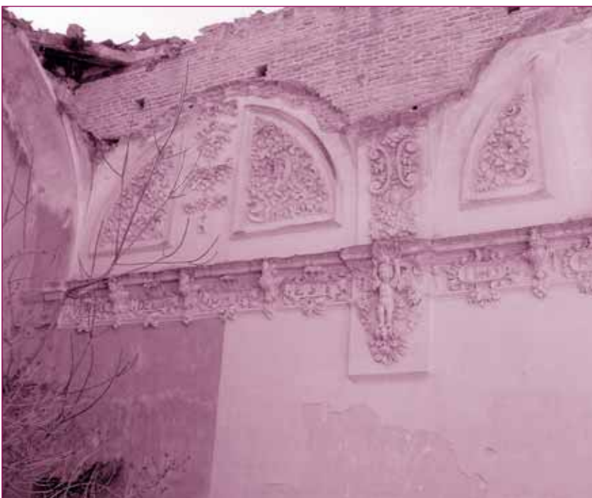
Sala Capitular. Era un salón rectangular, cubierto con bóveda de cañón, situado a la derecha de la iglesia. Entre 1720 y 1730 se decoró con yeserías dentro de lunetos y en un friso situado a media altura. Presenta actuando de «modillones» imágenes de niños como si de «atlantes» se tratara.
