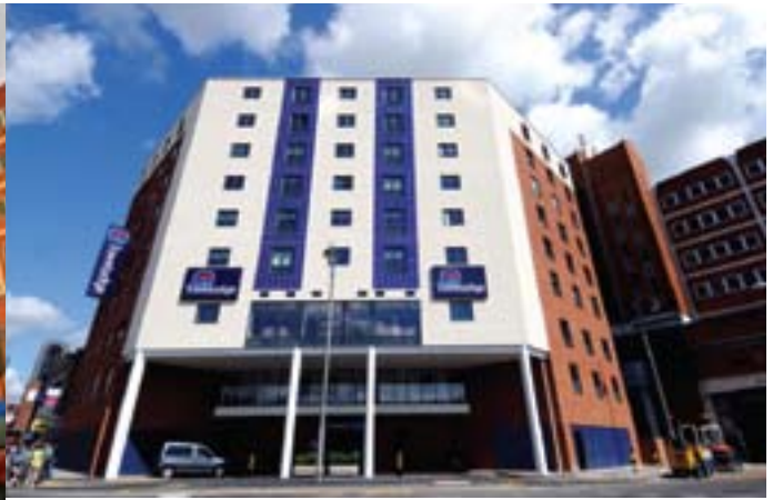
חזיתו של מלון "טראבלודג' ברובע אוקברידג' בלונדון (מימין) אינה חושפת כי הוא הורכב ממכולות פלדה, שהונחו על גבי שלד פלדה לגובה של שמונה קומות (משמאל)
