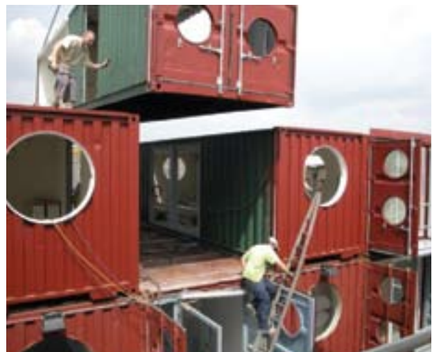
בריטניה. מרכיבים מבנה מכולות למגורים תוך יום אחד. לאחר שבמכולות הותקנו בהן דלתות וחלונות, וחלק מדפנותיהן הוסרו, מניח אותן מנוף זו על גבי זו ליצירת מבנה
