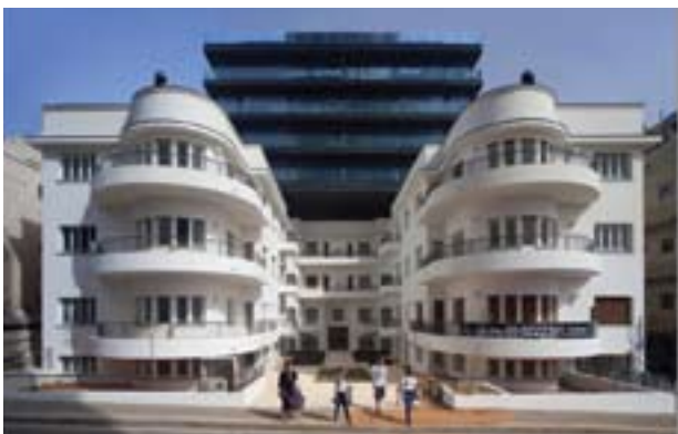
"בית רייספלד" כיום, לאחר השלמת שימורו חזיתו, שיחזור חלקו האמצעי ובניית מבנה חדש בחלקו האחורי המחופה במתכוון בזכוכית שחורה להבדילו מהמבנה הלבן
