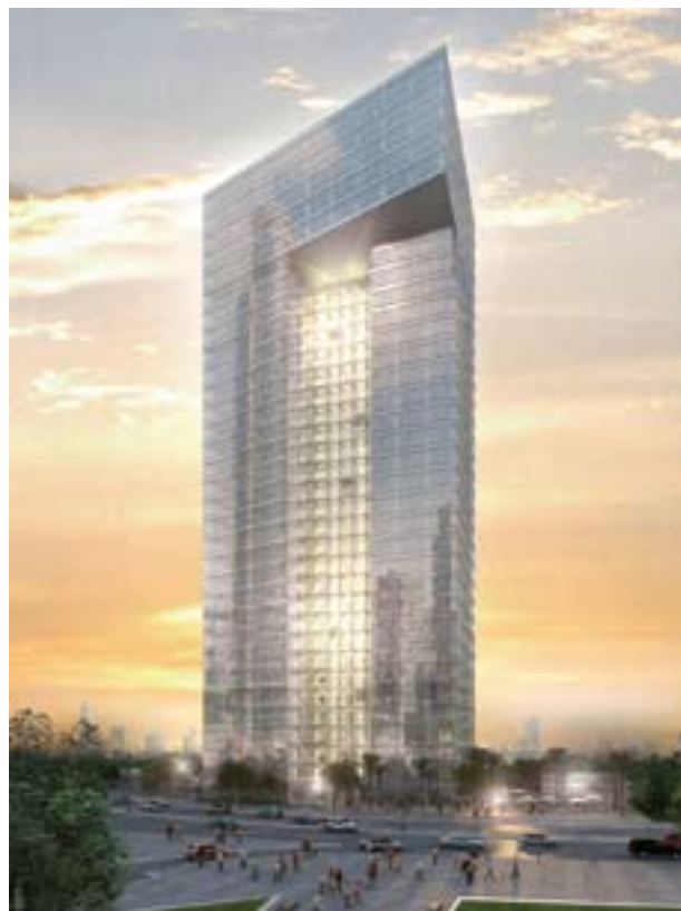
תמונת הדמייה של מגדל "אמות אטריום", שתוכנן על-ידי האדריכל משה צור. המגדל בן 38 הקומות יתנשא מול בניין בורסת היהלומים ברמת-גן בגובה של כ-150 מ'
