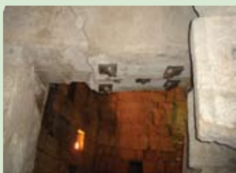
המשקוף בחדר החשמונאים - מנהרות הכותל ביסוס ועיגון הקמרונות
