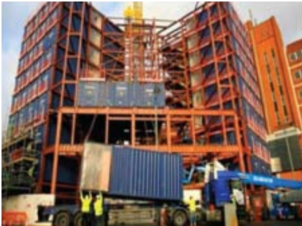
חזיתו של מלון "טראבלודג' ברובע אוקברידג' בלונדון (מימין) אינה חושפת כי הוא הורכב ממכולות פלדה, שהונחו על גבי שלד פלדה לגובה של שמונה קומות (משמאל)
