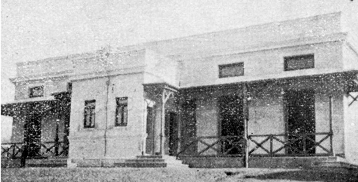
■ Las primeras construcciones del Hospital de Aislamiento instalado en la antigua casa de campo de Doroteo Enciso.
