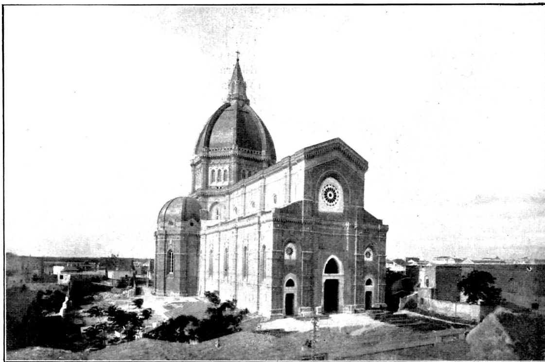
LE MACERIE E LE COSTRUZIONI CHE INGOMBRANO LA PIAZZA.
