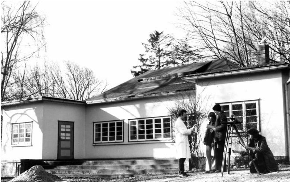
Abb. 5-1: Kurshaus der Biologischen Station Hiddensee, erbaut 1934. (Foto: M. Hübel, 1975)
