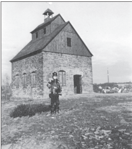
Ein Schachthaus von 1851 mit Wächterglocke zur Kontrolle eines untertägigen Wasserrades Foto: Herbert Pforr
