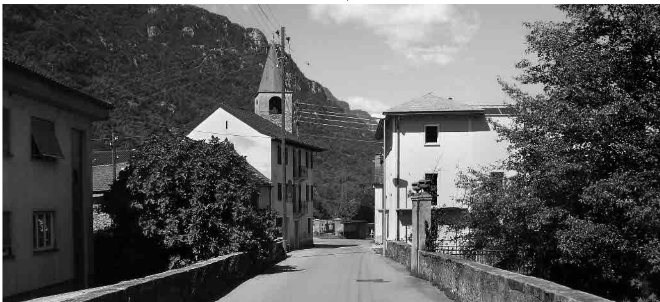
2 In accesso dal ponte sul Riale di Moleno
