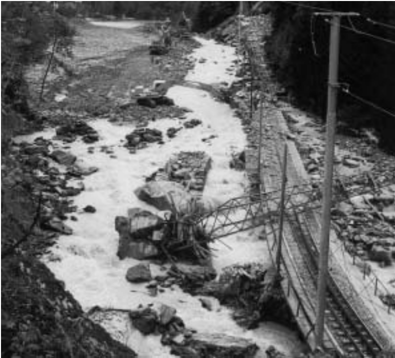
Am 24. September 1993 war der «Ritigrabu» ausgebrochen. Die Vispa wurde eingestaut und floss dann über die Sälibrücke (Foto 26. 09. 1993).
