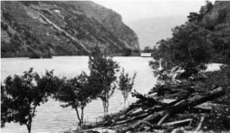
Am 12. Juni 1907 ragte vom Stall im Stundhaus nur noch das Dach aus dem Wasser. Heute steht dort das Depot der Bauunternehmung Regotz & Furrer AG (alte Postkarte).
