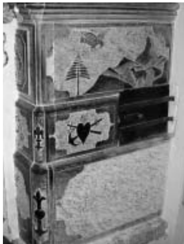
Ofen von Raphael Grichting: Die eine Ofenhälfte beheizt ein Zimmer, die andere den Raum jenseits der Wand (Haus Oswald und Marie Hischier-Grichting, Unterems).
