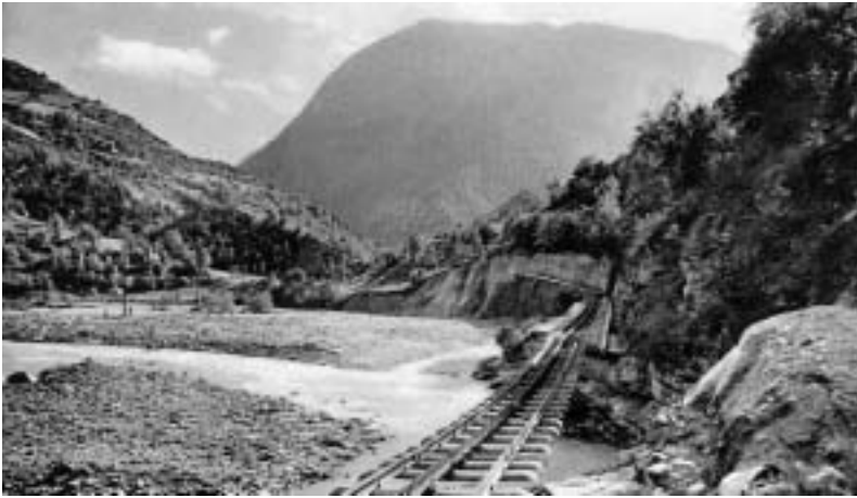
Am 24. September 1920 wurde im Ackersand das BVZ-Geleise unterspült. Ungefähr hier stand früher der Weiler «Bodme» (Foto S.A. Schnegg).
