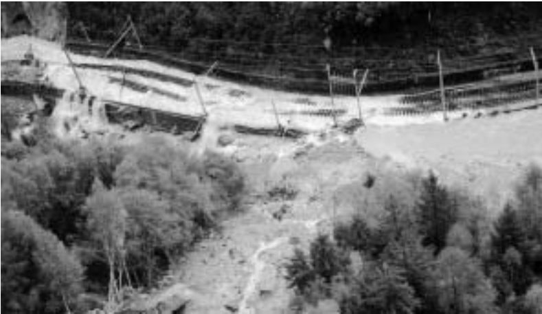
Am 15. Oktober 2000 stürzten im «Bärgzigi» («Chipfe») grosse Felsblöcke ins Flussbett und verstopften die Vispa. Das Wasser floss auf 300 m über das BVZ-Geleise (Foto 17. 10. 2000).
