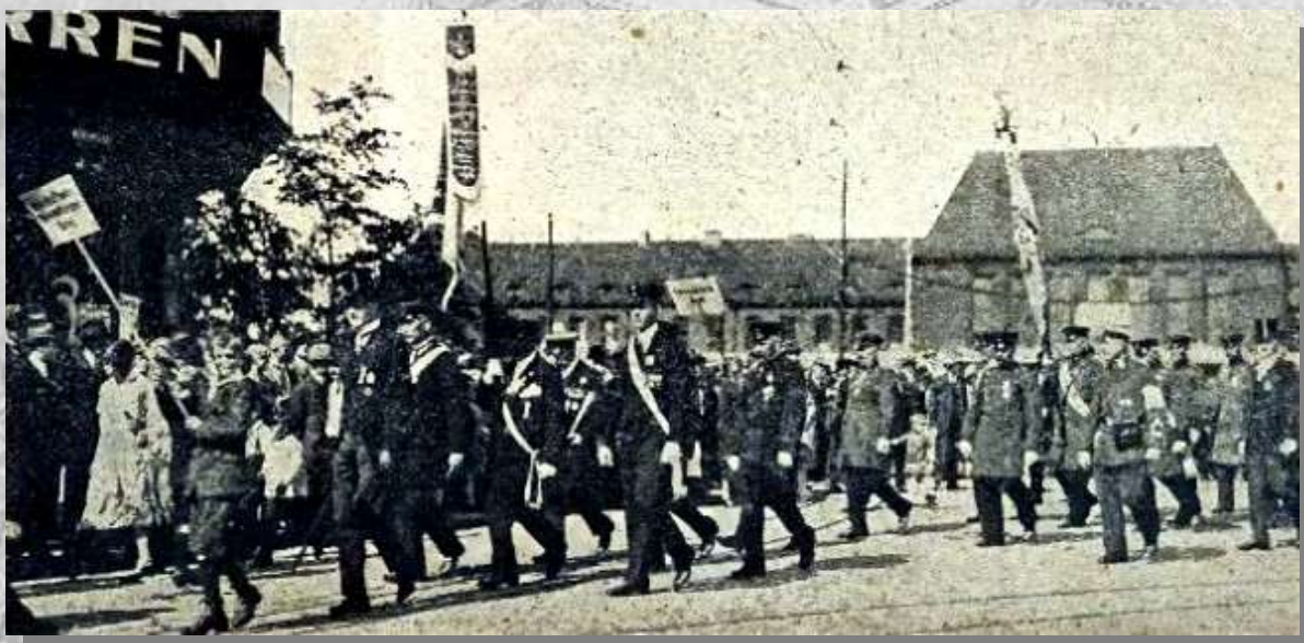
Na zdj.: Otwarcie nowego dworca kolejowego.
