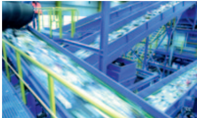
In den Aufbereitungsanlagen der Tönsmeier-Gruppe werden Wertstoffe aufbereitet, die anschließend Verwendung als Sekundärrohstoffe finden.
