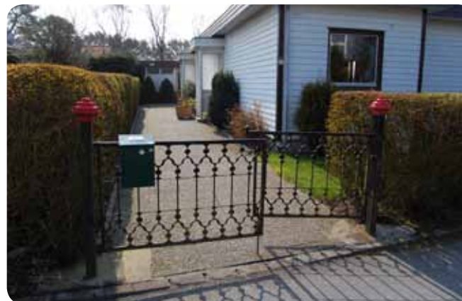
Enebolig på "Oljeberget" på Slåtthaug, borekroner på portstolpene viser at de som bodde her var ansatt i "olja"
