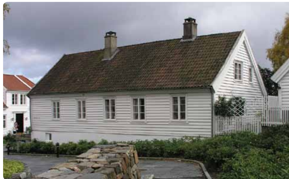
Blidensol, Øvre Strandgate 112
