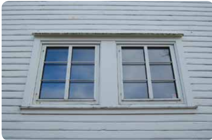
Tilbakeføring av vinduer er ikke alltid vellykket; her: falske sprosser, feil dimensjoner og galt listverk
