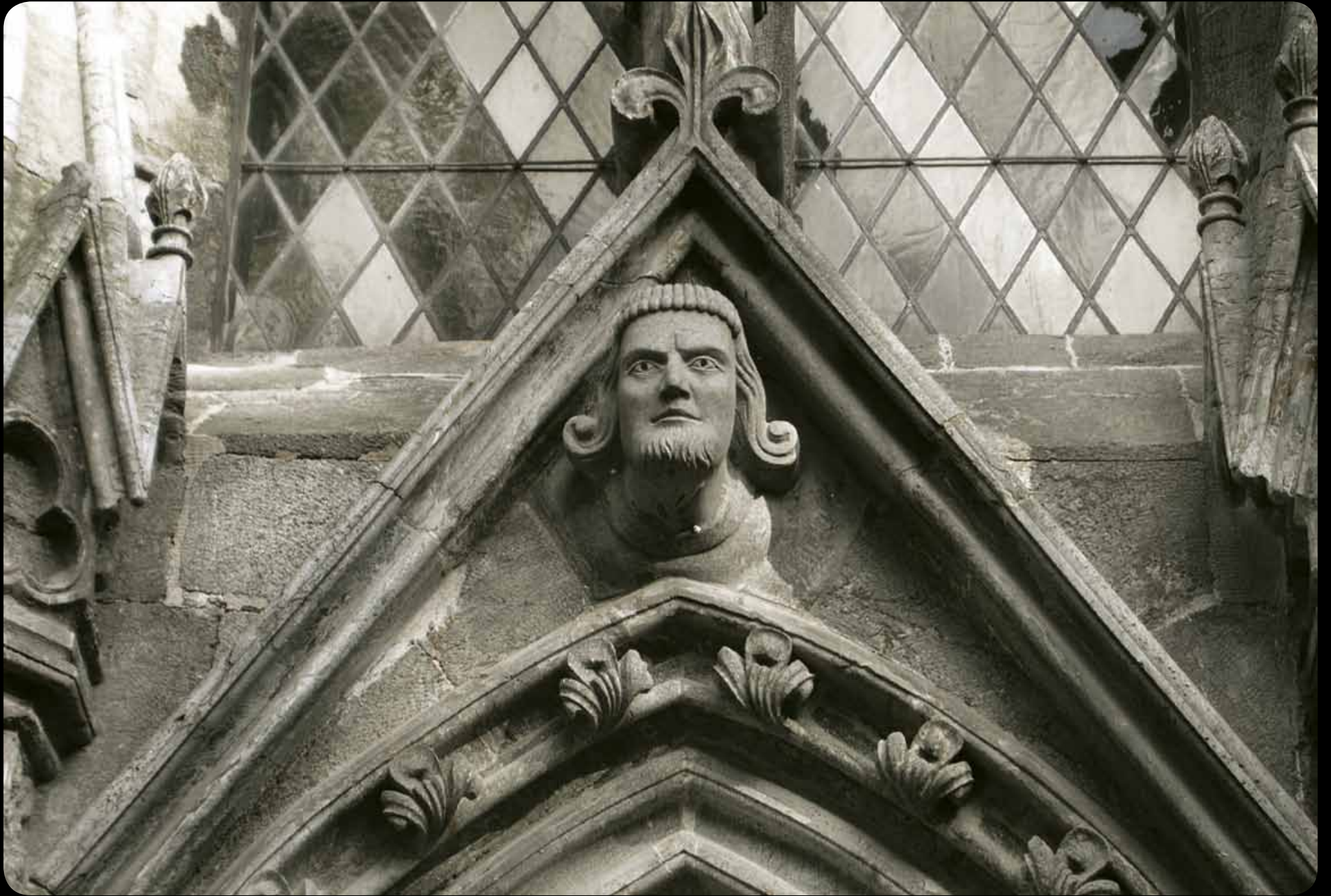
Detalj, Stavanger domkirke
