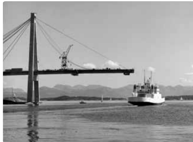
Bybrua under oppføring i 1977. Foto: Alf Brueland
