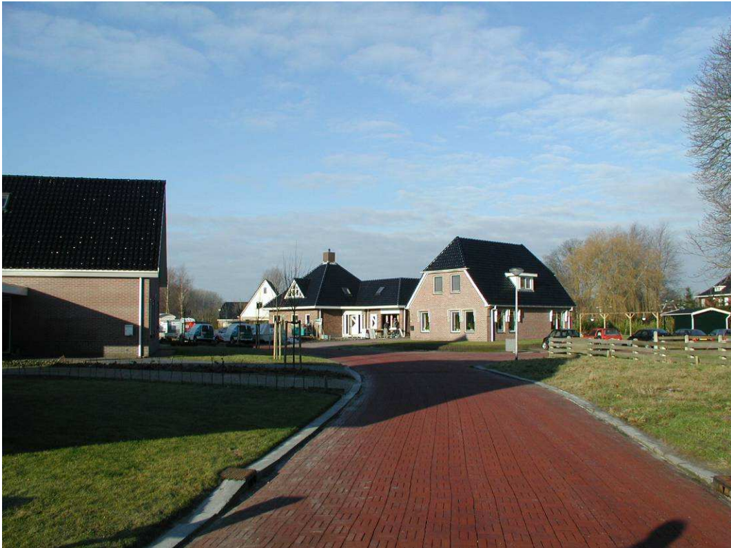
Wehe-den Hoorn: nieuwbouwlocatie 't Hoogje
