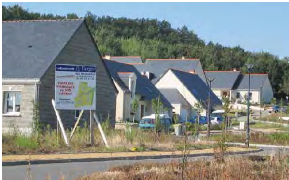
► A Bagneux, lotissement du Verger achevé en 2009 compte 32 logements qui se répartissent sur 26 885 m 2 .
