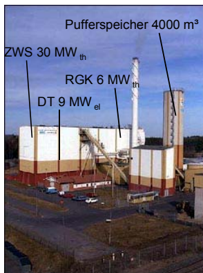
Biomasse-ZWS Heizkraftwerk Nassjö/SWE-Vattenfall mit 9 MW el , 20 MW th Fernwärme, 6 MW th Rauchgaskondensation und 4.000 m 3 Pufferspeicher; 1988 [Vattenfall 1996]
