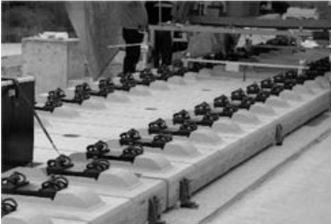
Bild V-35: Feste Fahrbahn System Bögl: Höhengenaues Einmessen der Betonfertigteileplatten auf der hydraulisch gebundenen Tragschicht (HGT)
