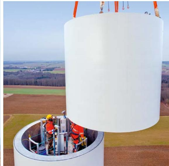
auf der Innenseite des Betonturms verlaufenden, externen Spannglieder, die im Spannkeller des Fundamentes ihr zweites Widerlager finden. Nach dem Aufbringen der Vorspannung und der Verankerung der vorgespannten Seile ist der auf diese Weise errichtete Spannbetonturm in sich tragfähig. Anschließend wird die erste Stahlsektion auf das Übergangsstück aufgesetzt und mit den werkseitig einbetonierten Ankerstangen des Übergangsstückes kraftschlüssig verschraubt.
