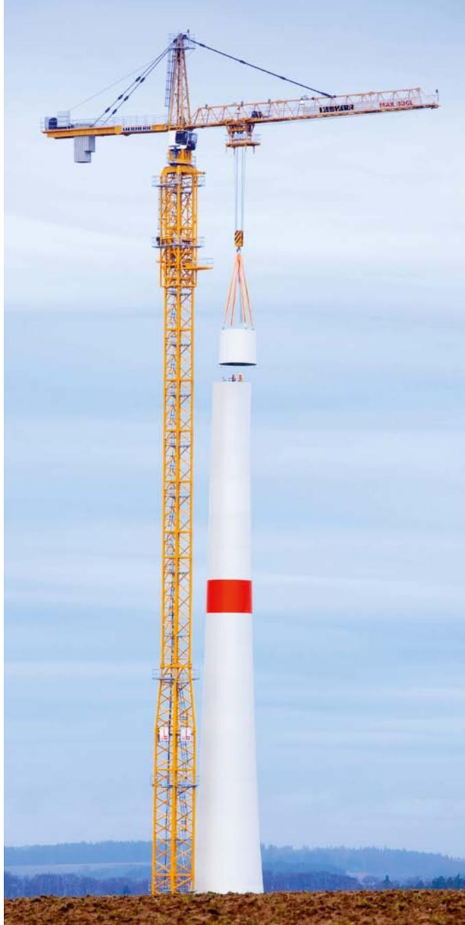
*Betonring um Betonring wächst der Hybridturm modular in die Höhe. Nach Einbau des Übergangsstückes erfolgt die Montage des Stahlschaftes als Turmspitze.*
