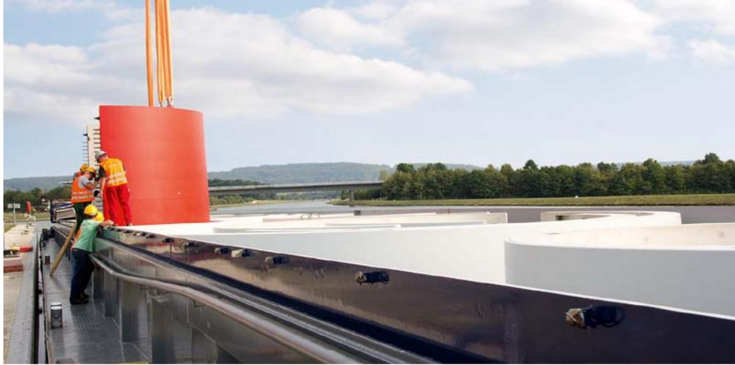
*Der Transport der bis zu 62 to schweren Betonfertigteile erfolgt durch den eigenen leistungsstarken Fuhrpark, aber auch zunehmend per Schiff über den Rhein-Main-Donau-Kanal.*
