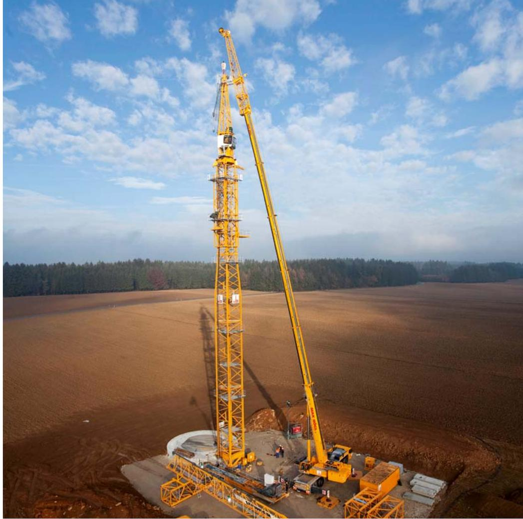
*Das erste Drittel des Turmdrehkranes wird mit einem Mobilkran montiert, dann beginnt der Kletterprozess für die Montage der Beton- und Stahlsegmente.*
