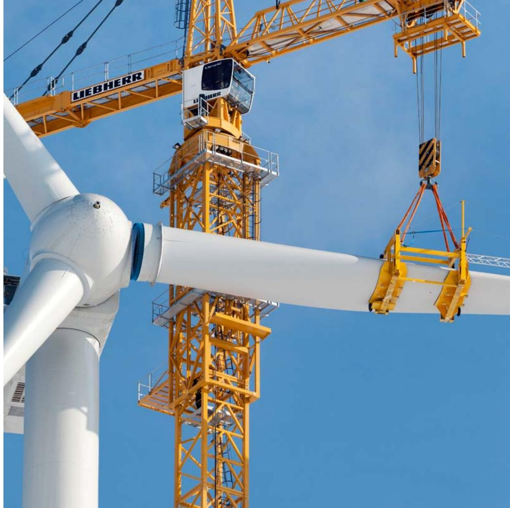
• Noch bei Windgeschwindigkeiten von 20 m/s werden die bis zu 70 to schweren Bauteile des Windkraftturms mit dem modifizierten Turmdrehkran in Position gehoben.
