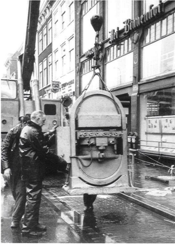
De zetterij van Het Binnenhof bevond zich op de bovenste etage van het gebouw aan de Prinsegracht. Het optakelen van de technische apparatuur trok er zo nu en dan de aandacht.
