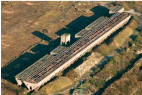
Der Kohlebunker wird zum Solarkraftwerk.
