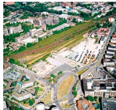
Auf dem Gelände des ehemaligen Großmarktes soll das neue Universitätsviertel entstehen.
