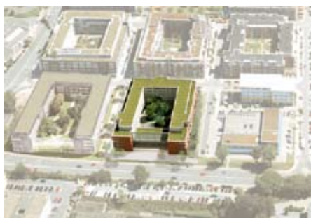
Weststadt Office S05 – Büroneubau in Essen
