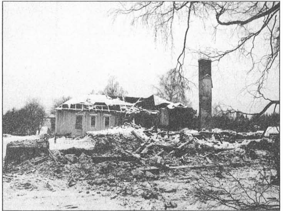
Sairastosasto paloi maan tasalle ja yleinen osasto tuhoutui käyttökeltomaksi.
