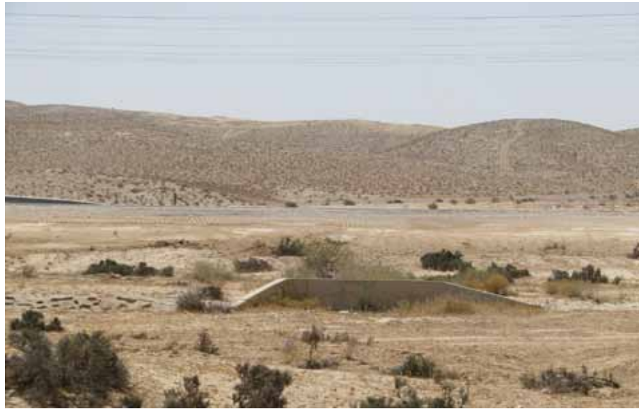
גשרון מעביר מים שאינו בשימוש לאורך התוואי הישן של כביש 40 בקטע באר שבע – צומת הנגב. ברקע נראה הכביש החדש אשר חוסם את מעבר המים ללימן, וזאת כיוון שלא מוקם בו מעביר מים
