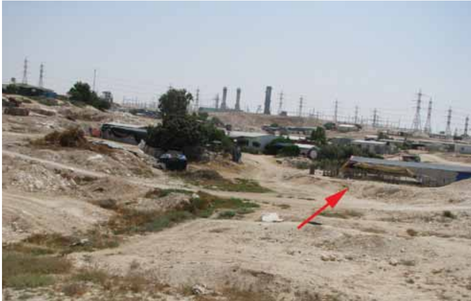
ערוץ ושטח תורם נגר ללימן לאורך כביש מספר 40, אשר נחסם ע"י סוללות עפר של התיישבות בדואית (מסומן בחץ אדום) ואתר של חברת חשמל, אזור רמת חובב.
