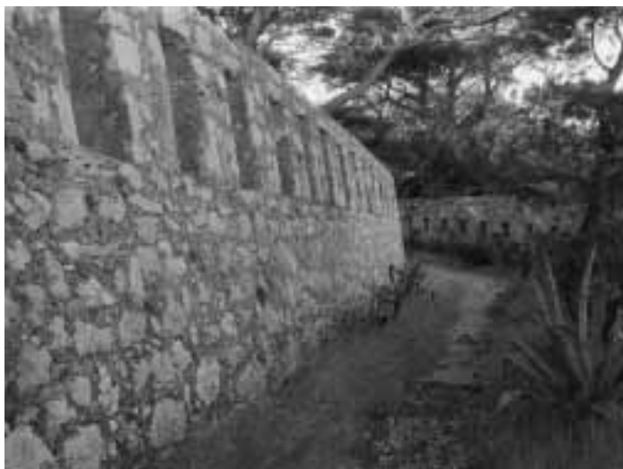
Puškarнице koje je podigla Austrija. Na jednom kamenu uklesano je 1848. Snimio Božo Gjukić.
