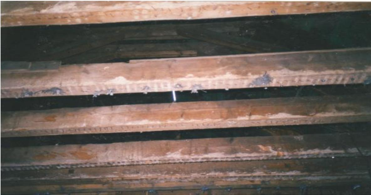
*Die ganze Decke des Kirchenschiffes ist entfernt, man sieht gegen die blanke Balkenlage.*
