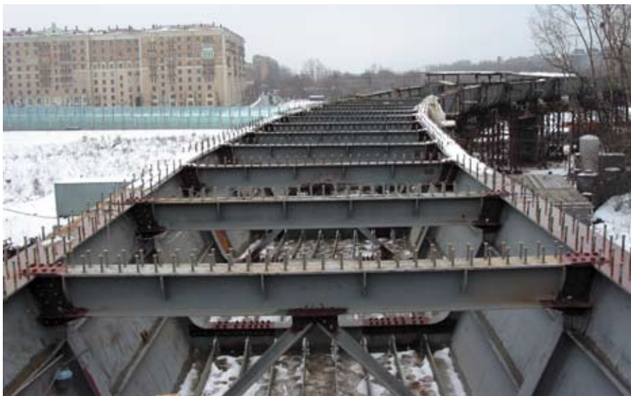
Рис. 2. Сталелезобетонное пролетное строение
