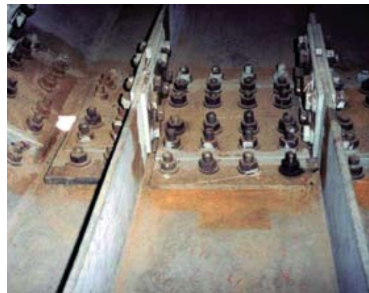
Рис. 10. Болтовой монтажный стык нижней плиты блоков 34-35, выполненный с вертикальным уступом до 36 мм
