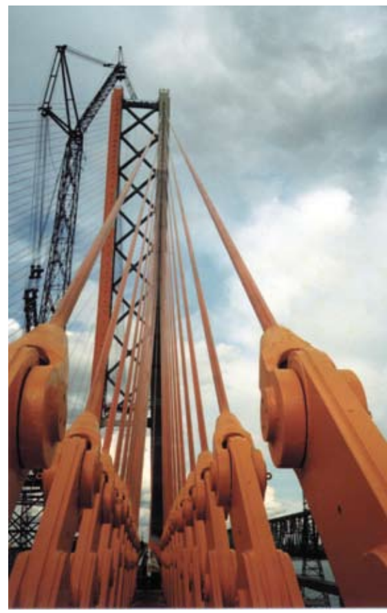
Рис. 4. Прикрепление вант к анкерной опоре 1
