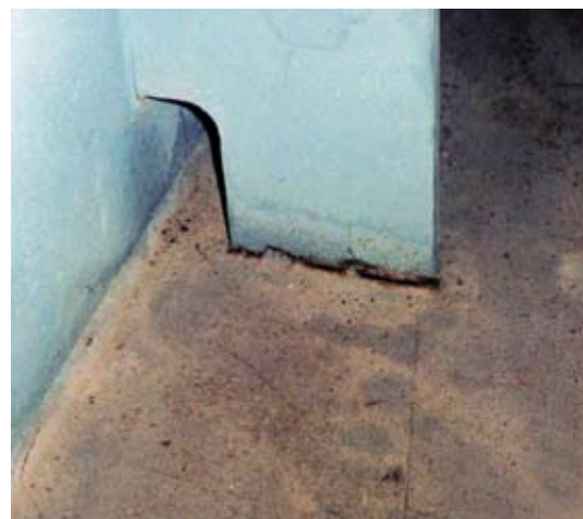
Рис. 9. Трещина в заводском угловом сварном шве крепления вертикального ребра жесткости главной балки к нижнему поясу
