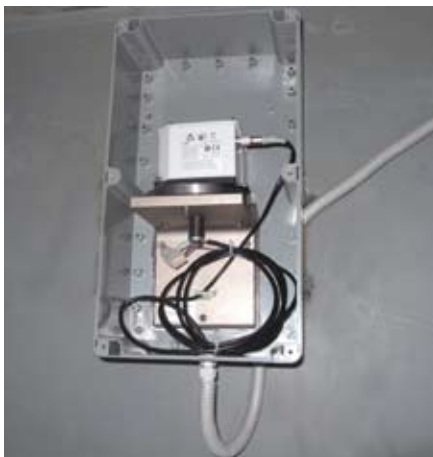
Рис. 6. Установка инклинометра NIVEL220 на нижней перемычке пилона М7 (отметка +65 м)
