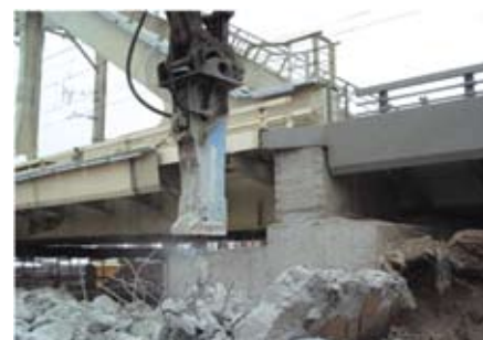
Рис. 1. Демонтаж существовавших конструкций и временной опоры
