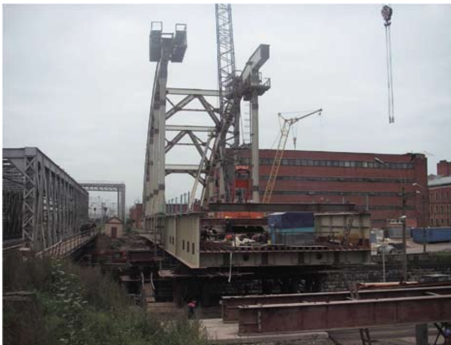
Рис. 4. Монтаж элементов арки
