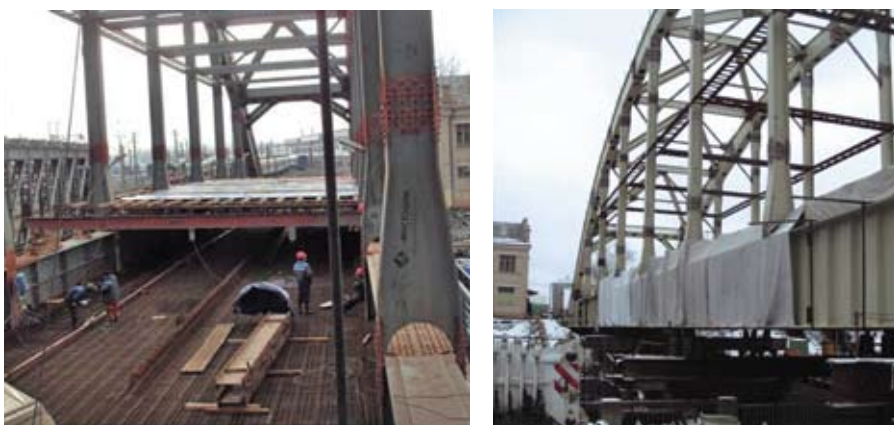
Рис. 5. Подготовка к бетонированию плиты
