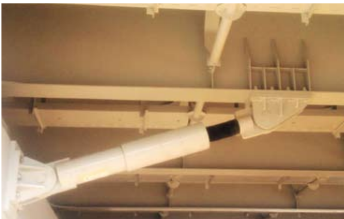
Рис. 3. Продольный демпфер между пролетным строением и опорой
