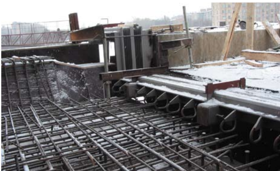
Рис.3. Устройство деформационного шва
