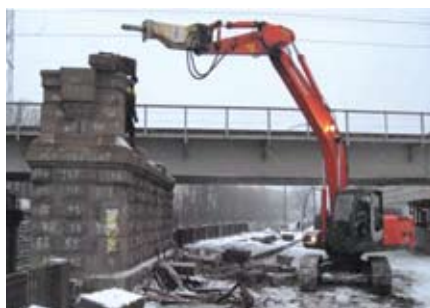
Рис. 1. Демонтаж существовавших конструкций и временной опоры
