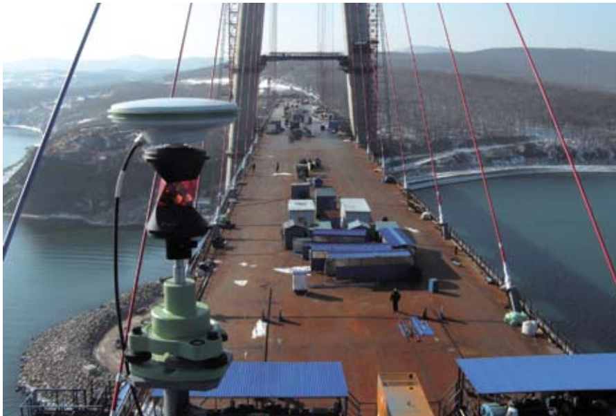
Рис. 2. Редуцированная точка на монтажном агрегате — антенна с отражателем
