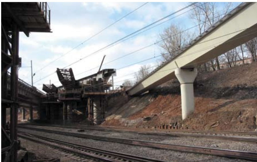
Рис. 4. Надвигка косоуго пролетного строения и использованием аванбеков разной длины
