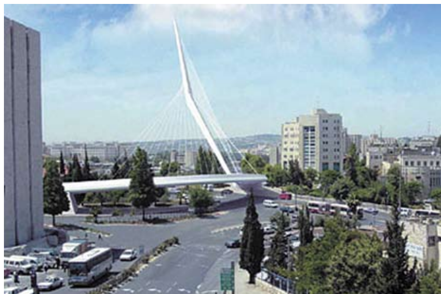
Рис. 2. Две струны построенного на въезде в Иерусалим вантового моста оборвались, не выдержав сильнейших порывов ветра. Еще недавно этот мост, спроектированный известным архитектором Колотравой по заказу бывшего мэра Иерусалима Эхуда Ольмерта, претендовал на статус «гордости столицы Израиля». Позже он стал одним из ненавистных жителям сооружений в связи с затянувшимся строительством, причинившим множество неудобств, а теперь эта конструкция представляет реальную опасность в одном из самых напряженных транспортных узлов этого города
