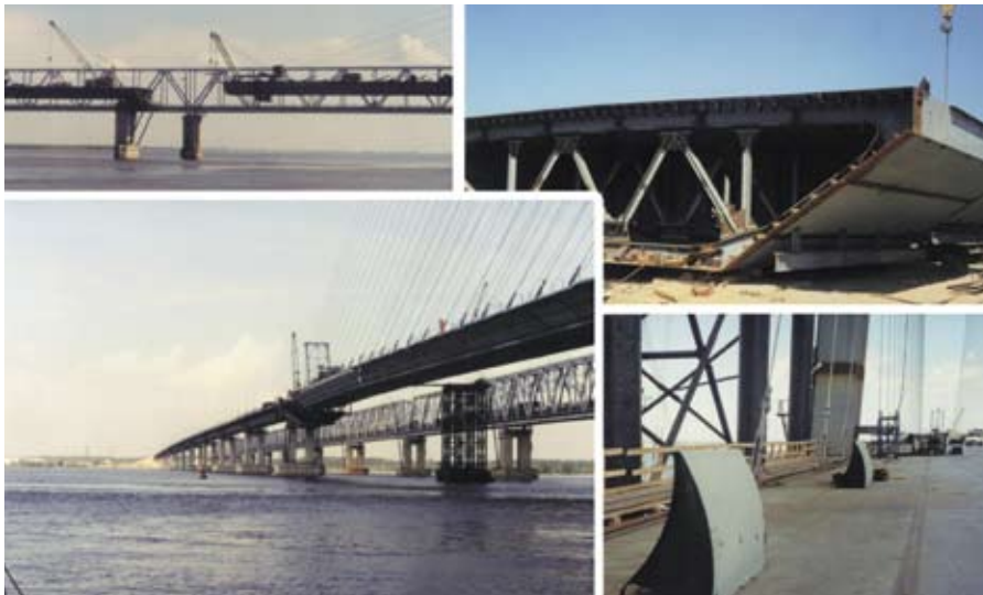
Рис. 8. Процесс монтажа блоков балки жесткости
