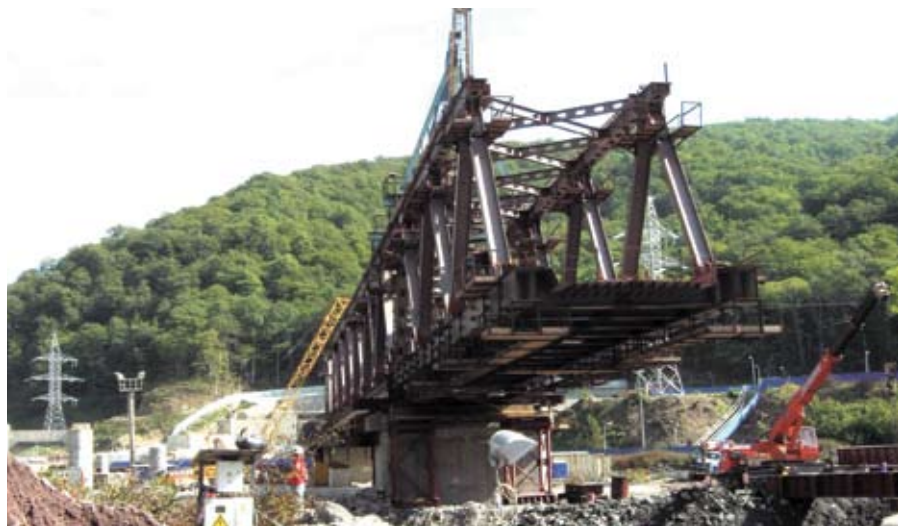
Рис. 5. Железнодорожное пролетное строение с цельносварным балластным корытом со сквозными фермами с ездой понизу в г. Адлере
