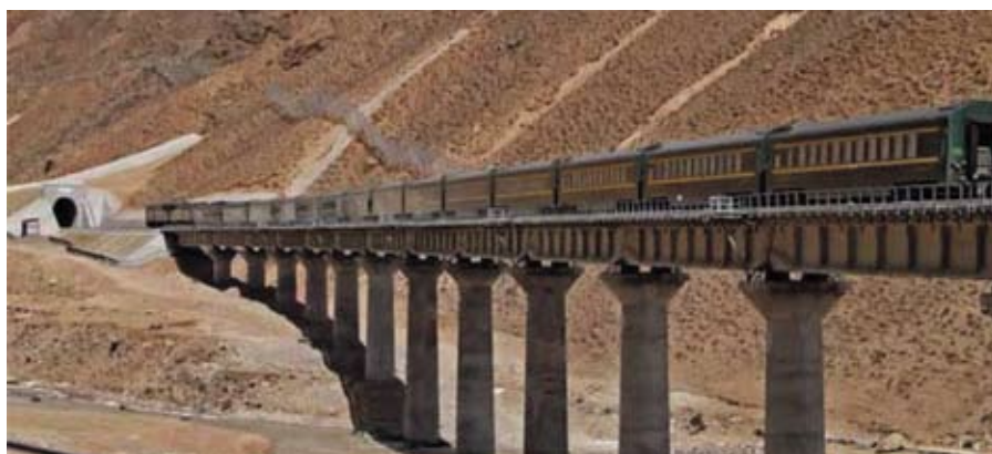
Тоннель Цинхай (Тибет)
