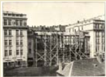
BUDOWA GMACHU PRZY UL. OKÓLNIK
