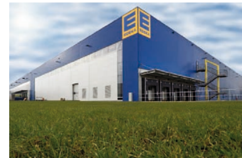
Das Lager in Osterweddingen wurde durch einen Anbau erweitert.
