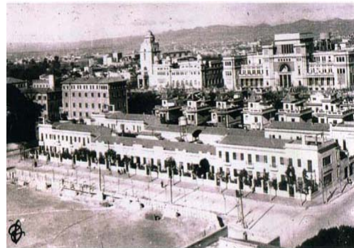
Vista aérea del desaparecido grupo de casas baratas de la Cooperativa de las Artes Gráficas, proyectadas durante la IIª República -1932- por el arquitecto Emilio Artal, demolidas en los años 70, así como los chalets de la cooperativa "Asociación de la Prensa", diseñados entre 1931- 34 por Enrique Viedma (archivo Enrique Giménez)
