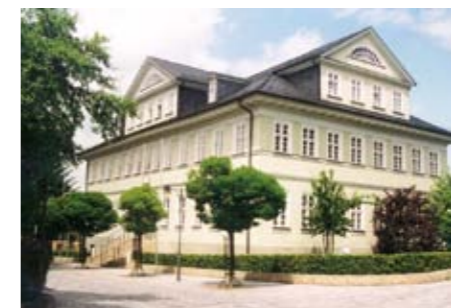
Glockenbergsschule Neustadt b. Coburg
