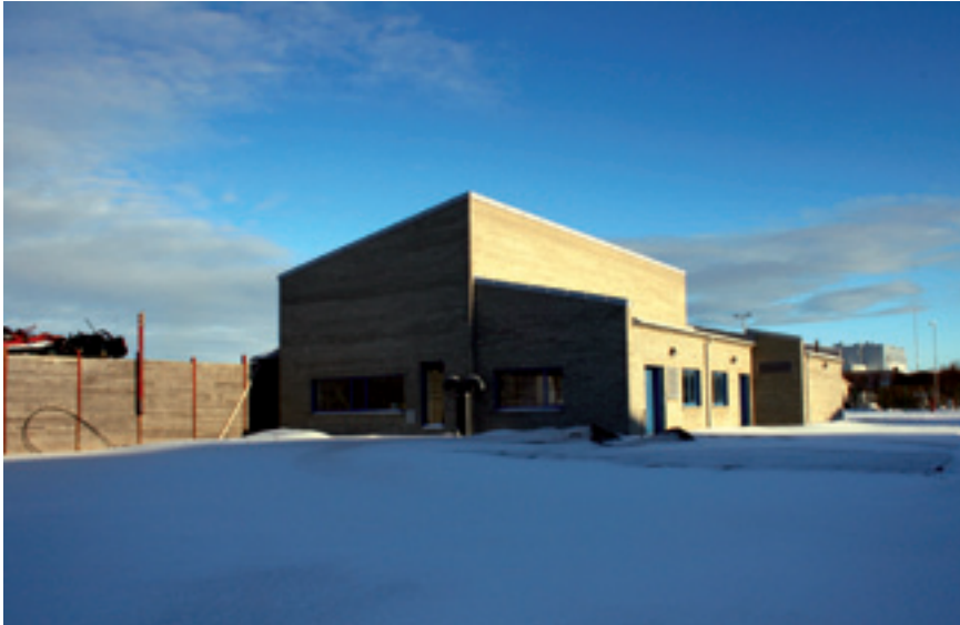
Hammervika renseanlegg ble satt i drift i oktober 2010.
