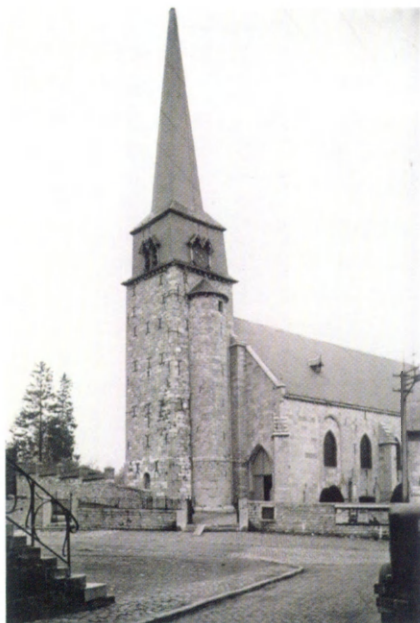
Fig. 1. – Vue générale de l'église Sainte-Rolende à Gerpinnes. © Centre d'Archives et de Documentation de la C.R.M.S.F., dossier Gerpinnes 1.1.
