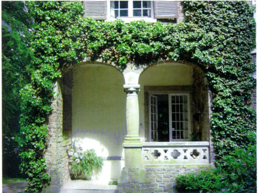
Fig. 8. - Villa Le Soyeureux à Spa : détail de l'auvent. © Soo Yang Geuzaine.
