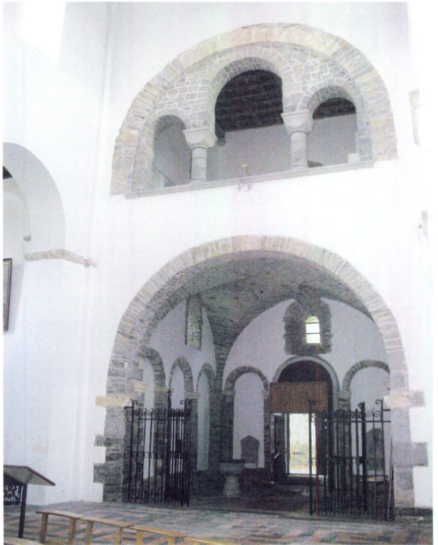
Fig. 4. - Vue intérieure du premier étage et du rez-de-chaussée de la tour. © Maud Layeux.
