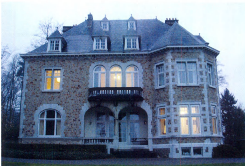
Fig. 6. - Villa du Baron Maurice Fallon : façade sud-est. © Soo Yang Geuzaine.
