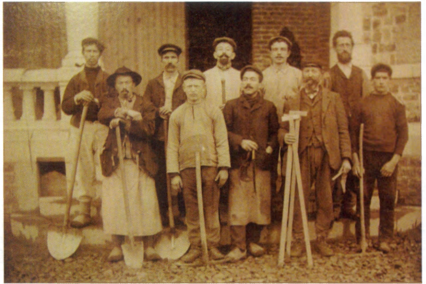
Fig. 5. - Villa du Baron Maurice Fallon : ouvriers d'entretien devant la terrasse de la façade sud-est. Collection privée.
