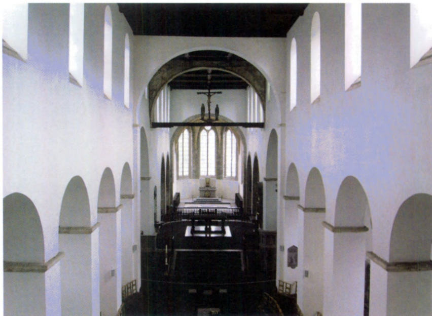
Fig. 10. - Vue d'ensemble de l'intérieur de l'église prise depuis la tribune. © Maud Layeux.
