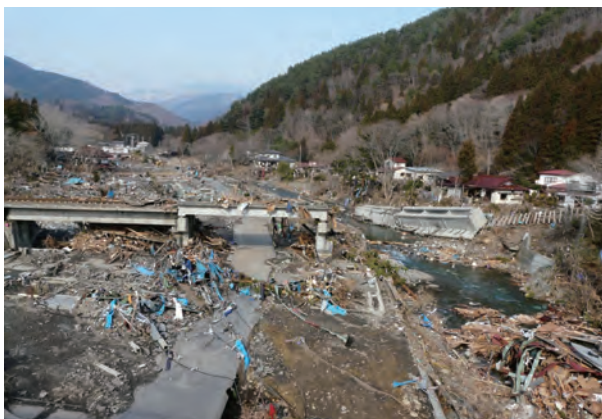
写真 2.3.15 流出した荒川橋梁付近の状況
