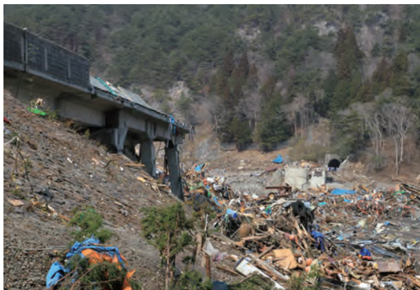
写真 2.3.1 駅と高架橋が流出した島越駅付近
