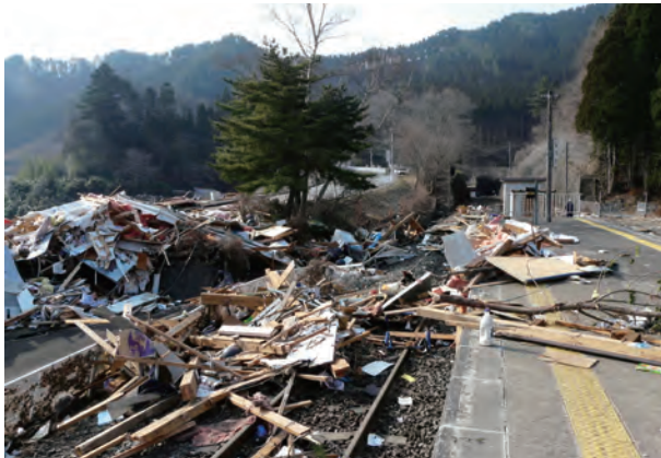
写真 2.3.12 津波が越流した とうに 唐丹駅
