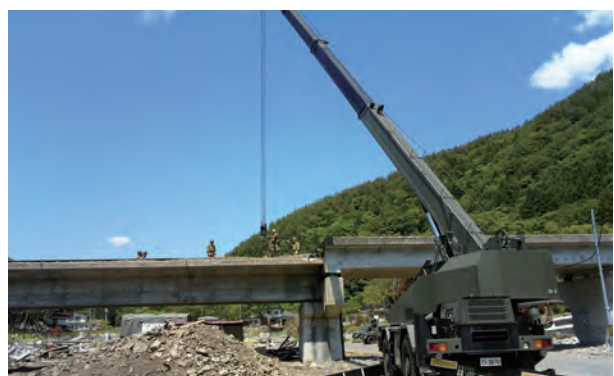
写真 2.3.25 荒川橋梁付近の瓦礫撤去を行う自衛隊
