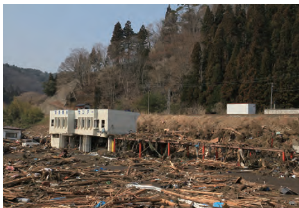
写真 2.3.10 土砂・瓦礫で覆われた田老駅前
