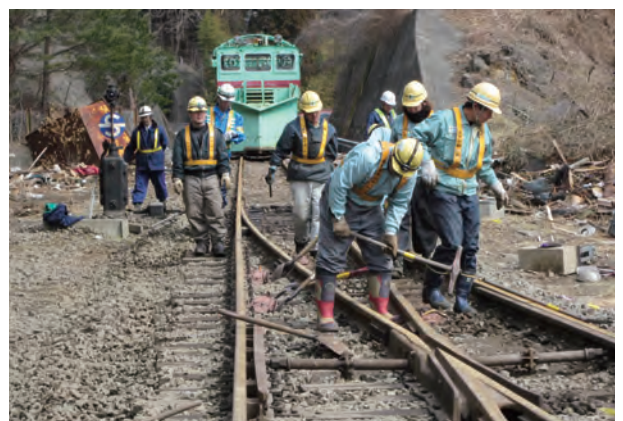
写真 2.3.17 社員による復旧作業の様子
