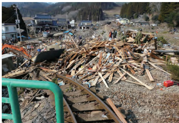
写真 2.3.5 津波でレールが流出した甫 ほれい 嶺 ほれい 駅付近
