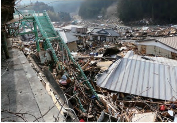
写真 2.3.11 津波の瓦礫が駅前に堆積した陸前赤崎駅
