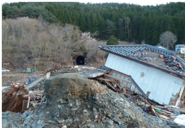
写真 2.3.4 波が築堤を破壊した泊地区
