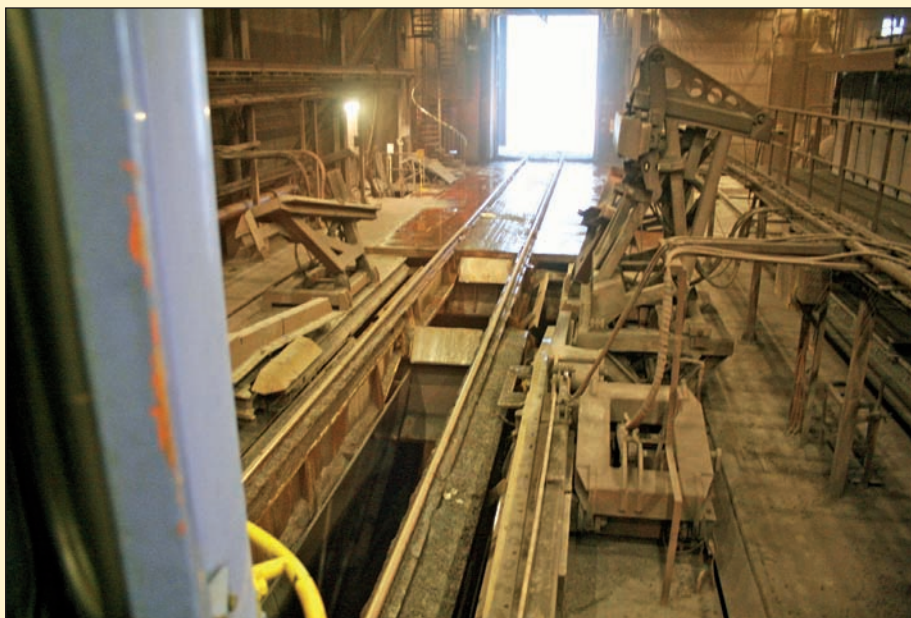
Siloen i lossehallens spor 4 etter renoveringen. (Foto: Trond Stiberg)
