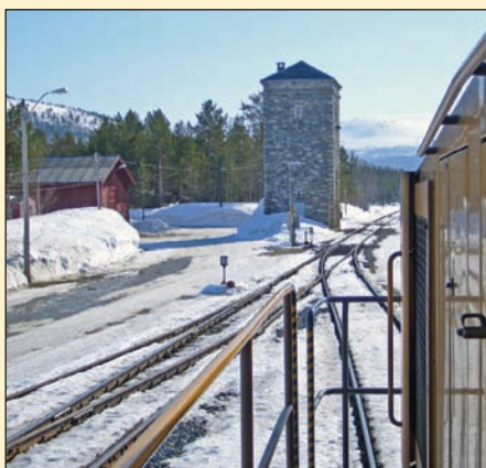
Bak vanntårnet skjuler det seg en planovergang. Hastighet over overgangen er 10 km/t.
