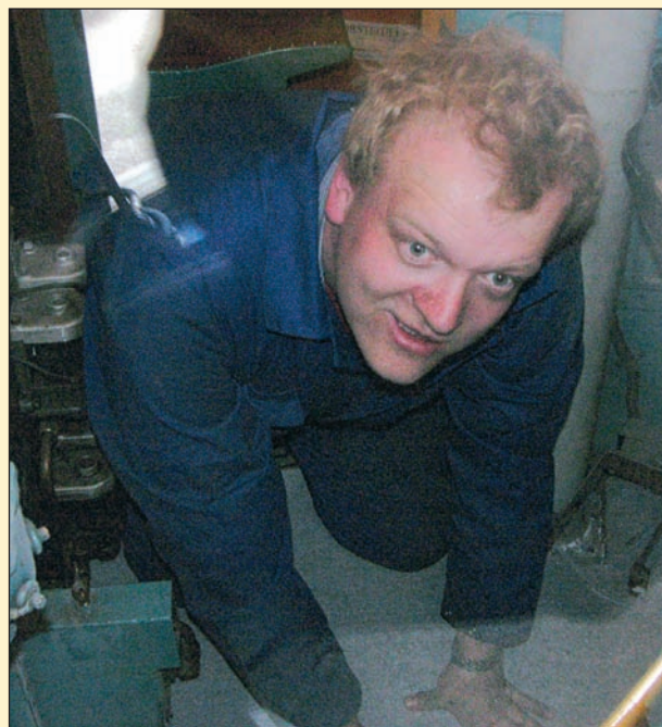
Hans Olav Fykop i gang med å bytte gulvbelegg i førerrom ende 2 i Valdresbanens BM86.12
