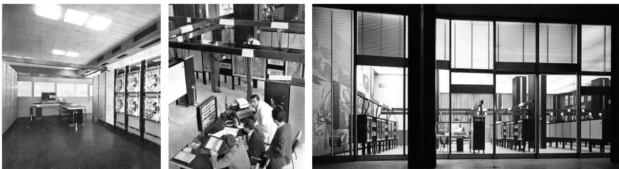
Il 9001, nell'installazione finale a Ivrea, e due immagini del 9002 nella sede di Milano.
