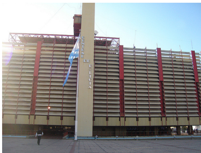
Figura 6.34: Edificio de la Central de Policía
