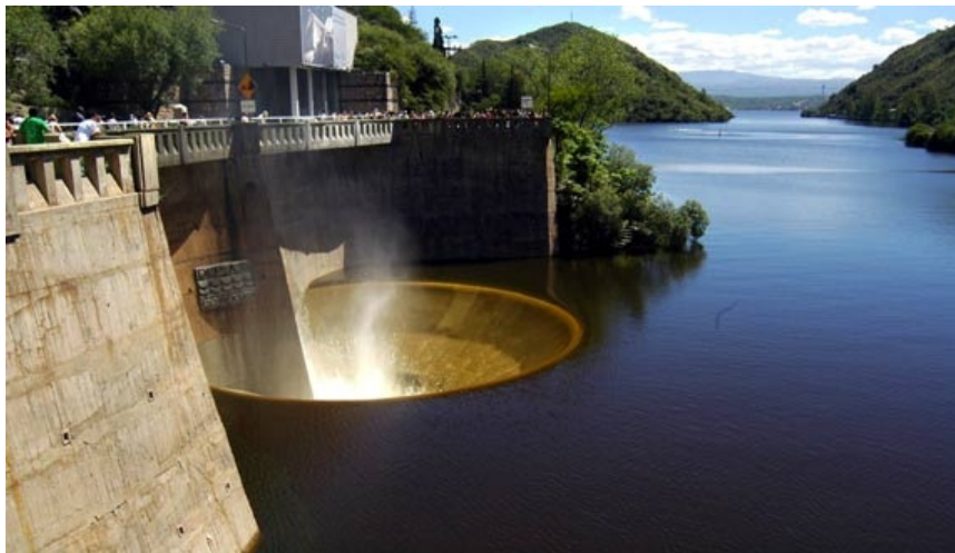
Figura 6.6: vista del vertedero embudo del nuevo Dique San Roque.
