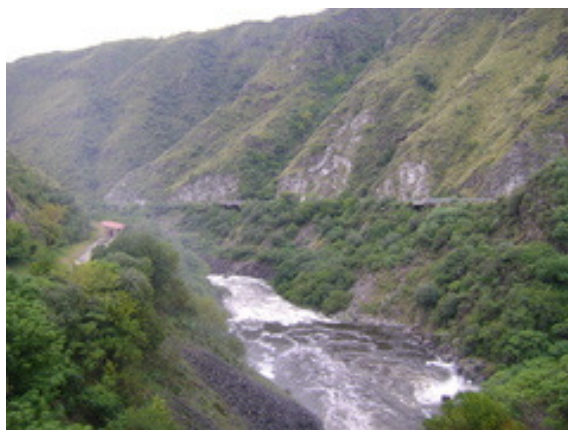
Figura 6.11: Vista del cauce aguas abajo desde el cierre
