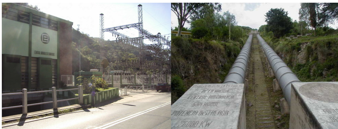
Figura 6.26: Central hidráulica San Roque
