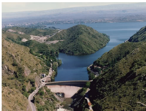
Figura 6.1: Vista desde aguas abajo del muro del dique San Roque.
