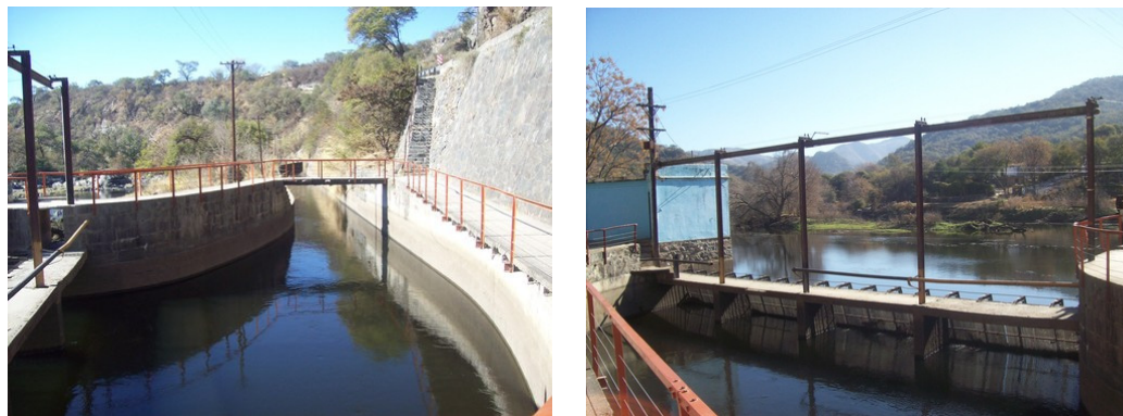
Figura 6.29: Obra de Toma en el Diquecito para la central La Calera.
