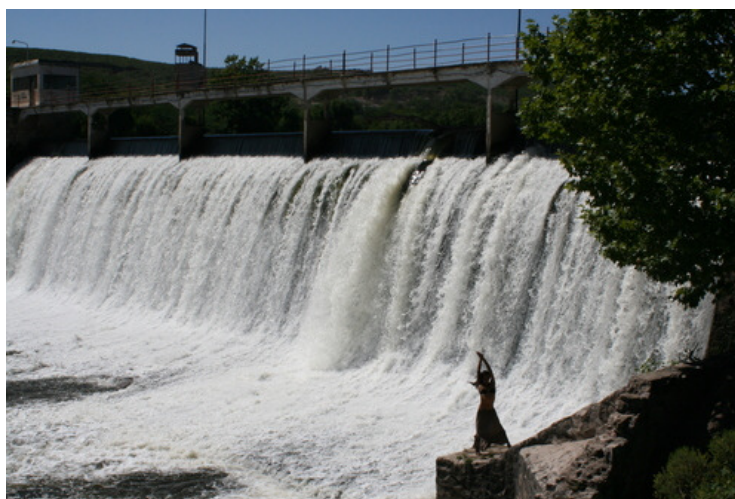
Figura 6.30: Dique Nivelador Mal Paso
