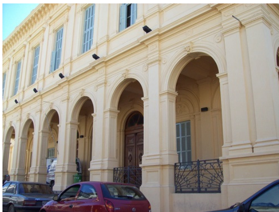
Figura 6.31: Fachada del Hospital Nacional de Clínicas
