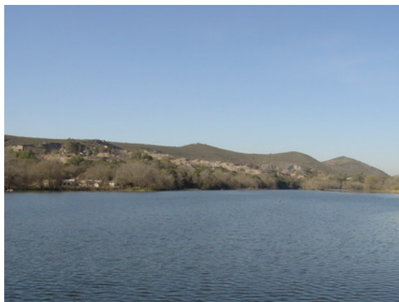
Figura 6.16: Dique Mal Paso
