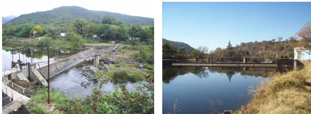
Figura 6.28: Azud El Diquecito
