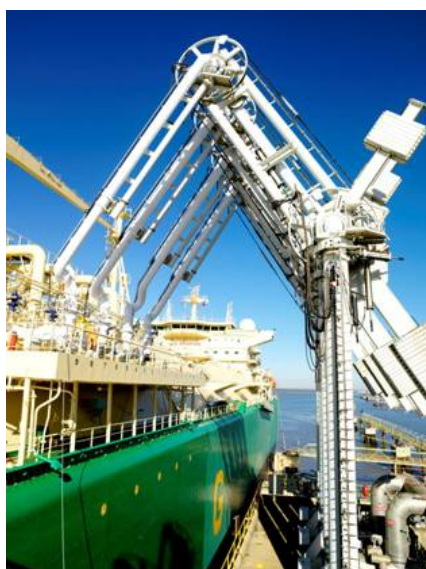
Figure 3-6: LNG Offloading Arms - Courtesy FMC
