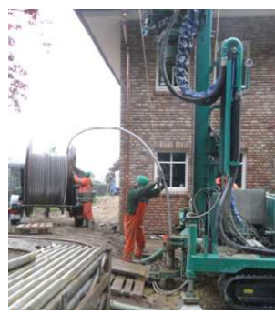
Abb. 19: Trommeleinbringung
