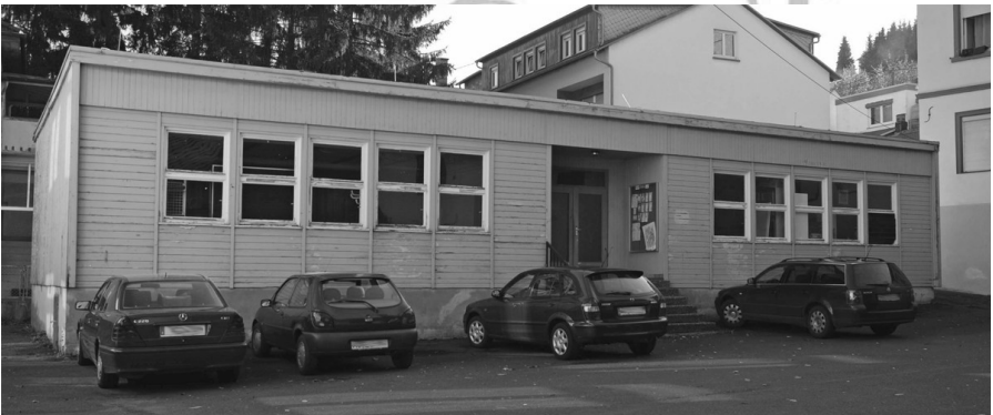
Der alte Pavillon 2012 - Unverkennbare Spuren der Zeit nagen an ihm. Quelle: [SE]
