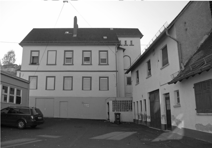
Die erste Schule aus dem Innenhof. Sie besaß ursprünglich nur 1 Stock. Rechts das 1965 gebaute Gebäude für die Heizungsanlage und Sanitäranlagen. Quelle: [SE]
