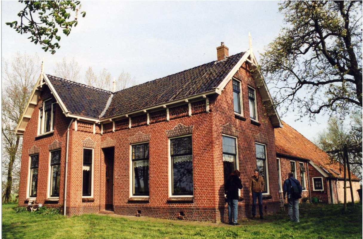
Afb. 8. Leegeweg 41, overhoeks genomen foto van het L-vormig voorhuis. Foto: Marcel Verkerk, dienst RO/EZ.
