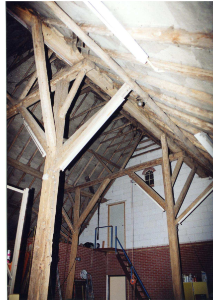
Afb. 17. Overzicht gebintconstructie. Foto: Marcel Verkerk, dienst RO/EZ.
