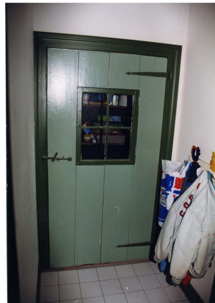
Afb. 14. Hergebruikte kelderdeur. Foto: Marcel Verkerk, dienst RO/EZ.
